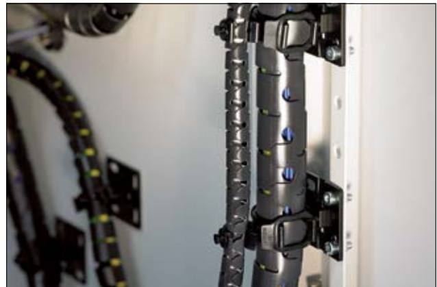
Schutz und Befestigung von Kabeln und Leitungen mit dem Helawrap Zubehör im Industriebereich, z. B. in Schaltschränken.
