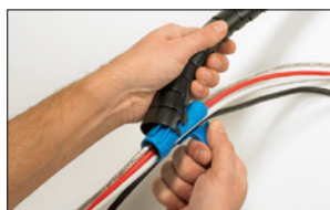
Helawrap wird nun nach dem Reißverschlussprinzip montiert.
